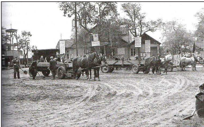
Rok 1967. Przygotowanie terenu pod budowę kaplicy w Bieńczycach – dziś Kościół „Arka Pana”.
